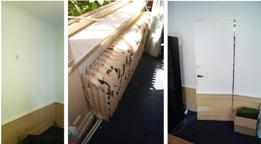
Afb. 43 t/m 45 Van links naar rechts: muur terraszijde met balkondeur; radiator; toegangsdeur
