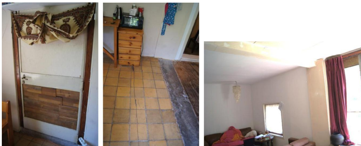
Afb. 49 t/m 51 Van links naar rechts: terrasdeur (dichtgezet), tegelvloer terras met overgang naar uitbreiding; overspanning terras oostzijde.
