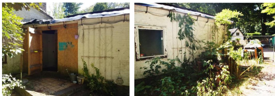
Afb. 11 t/m 16 Van boven naar beneden: nieuwe garage; oorspronkelijk garage; entree hal; schoorsteen; entree kleine hal; gevel met venster werkkamer.
