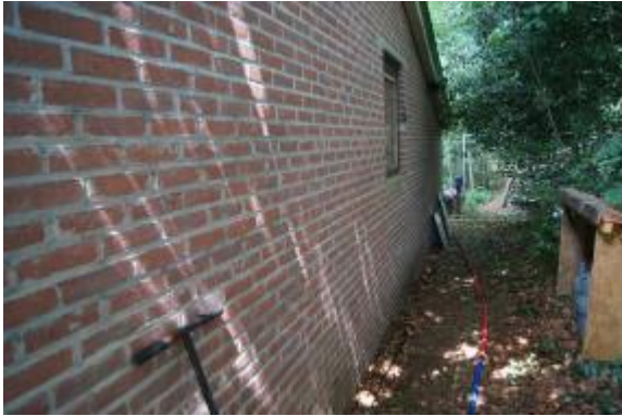
Afb. 10 Oostgevel van de nieuwe garage uit 2000
