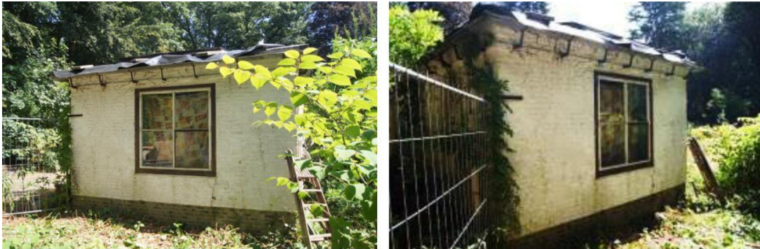
Afb. 8 en 9 Westgevel met een centraal geplaatst raam,
